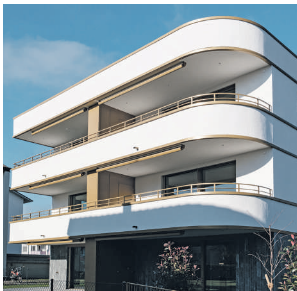
Aussenansicht des Neubaus MFH Aronda Thun.
